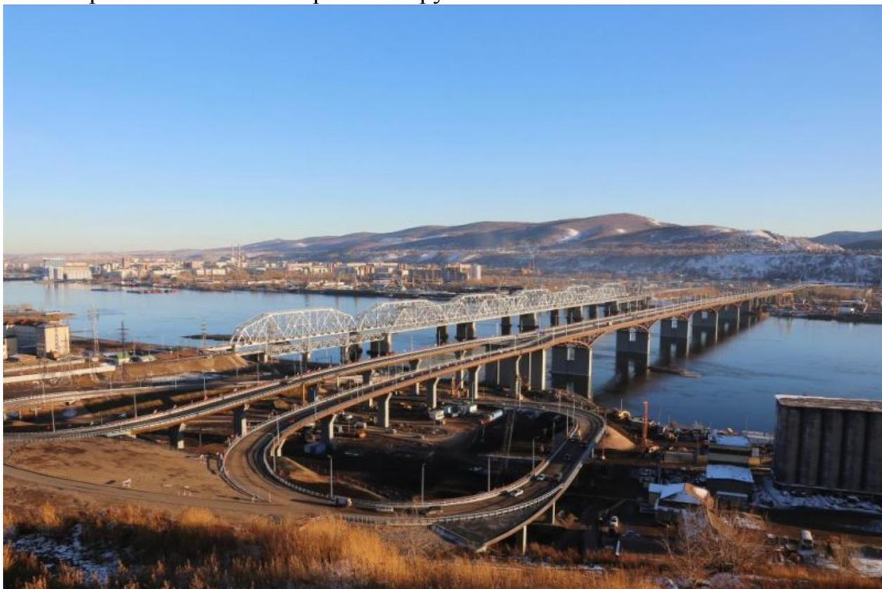
В Красноярске построен четвертый мостовой переход через реку Енисей. Общая длина моста 1000 м. Основной пролет – 140 м. Конструкция моста – однопутная фермовая.
