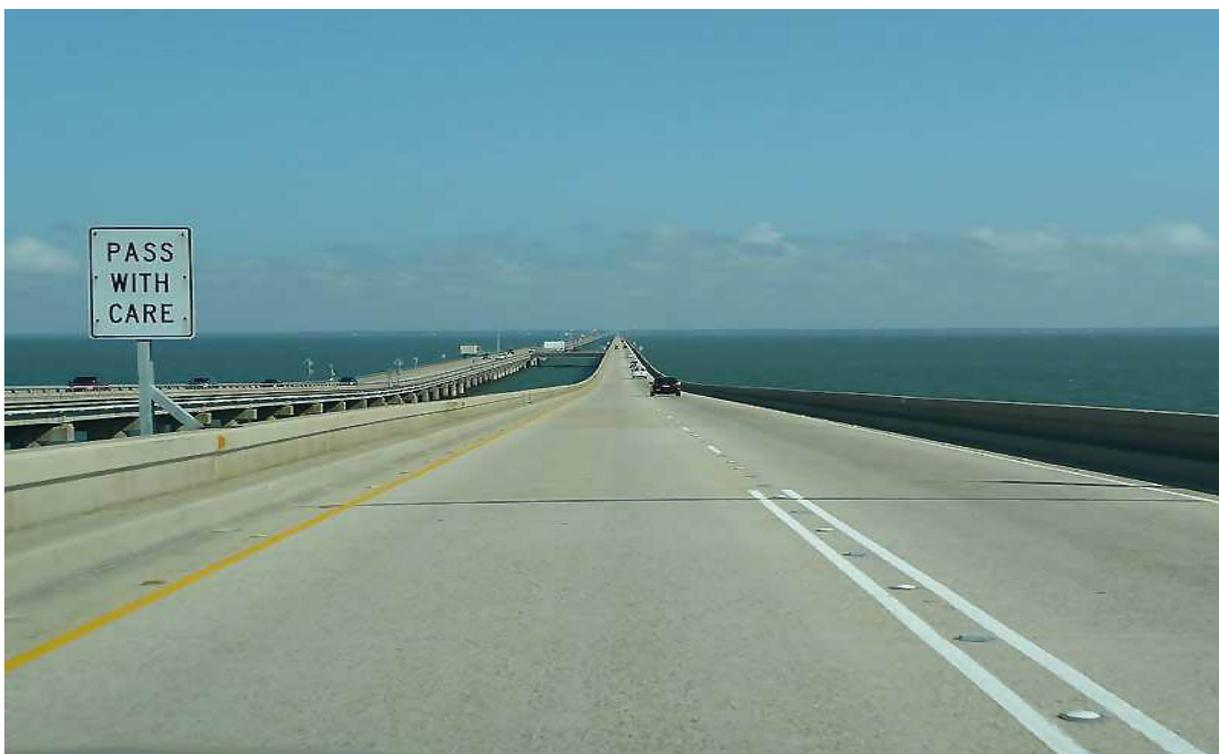
Мост состоит из двух самостоятельных дорог. Та, что длиннее – 38 километров и 420 метров. Общее число бетонных свай моста превышает 9 000!
